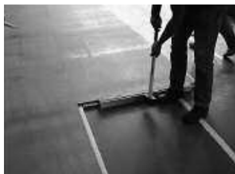
Utilisation d'une chute de panneau et d'un chevron (5 x 5 cm) et emboîtement à l'aide d'une masse.
